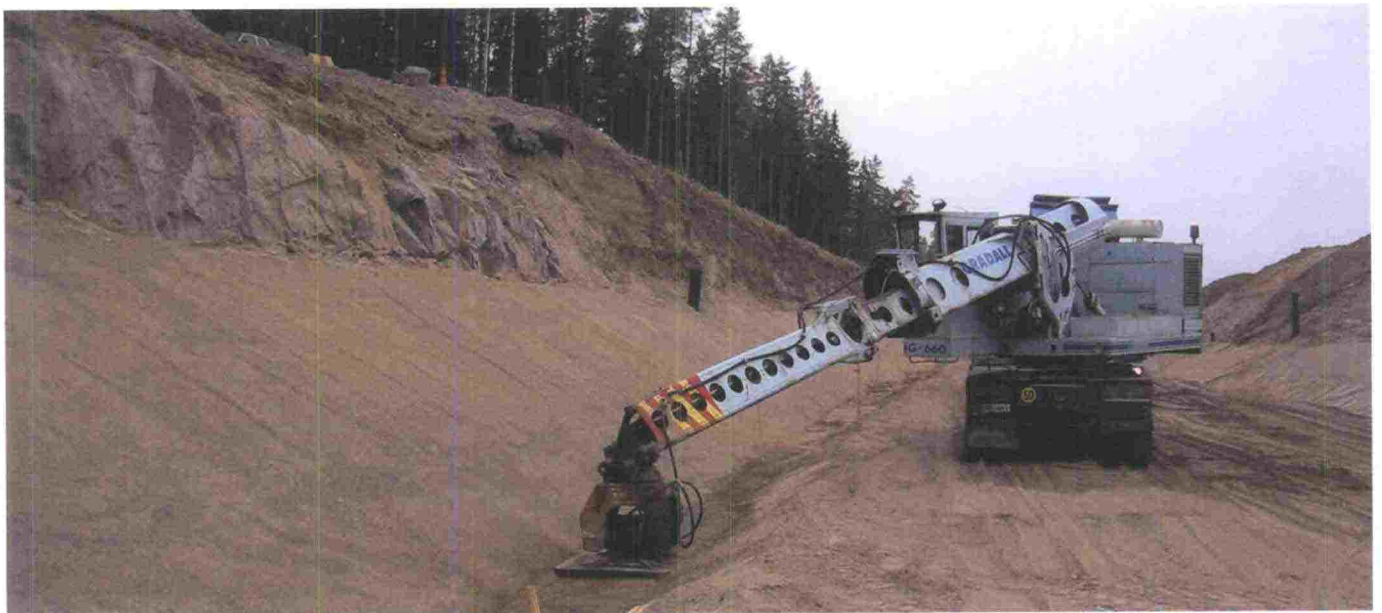
Kerava-Lahti-oikoradan työmaalla suojattiin Järvenpään Myllylän pohjavesialue.
