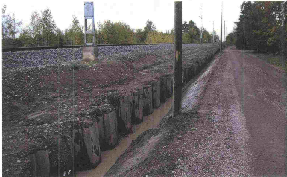
Mellilässä toteutettu ponttiseinä tärinän vähentämiseksi. Kyseinen koerakenne vähensi tärinän puoleen.
