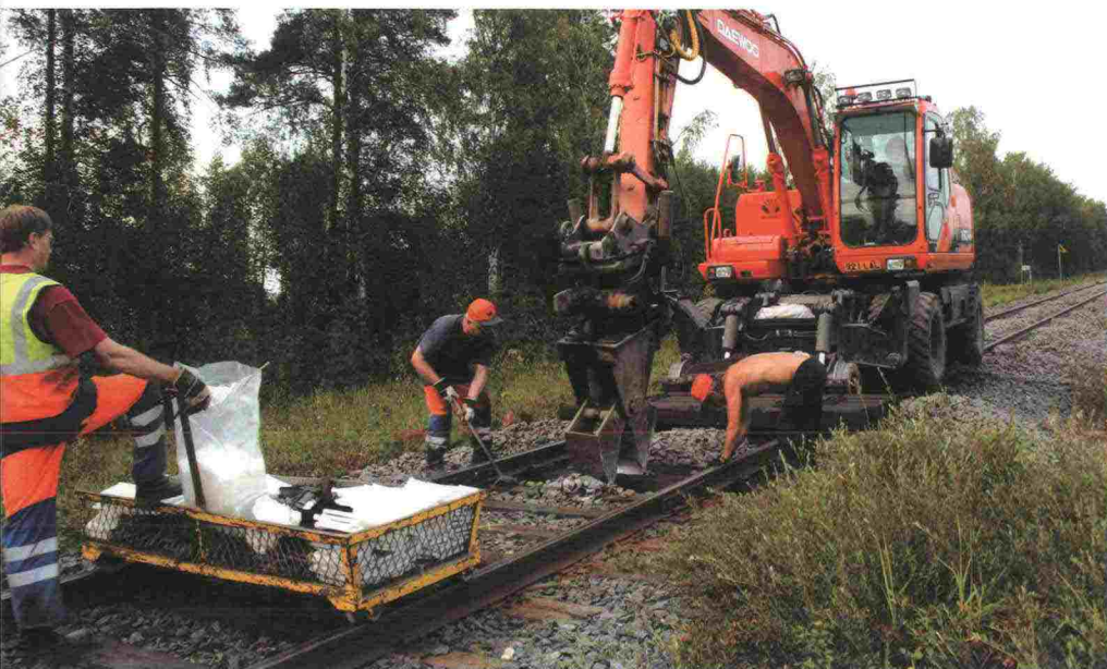
Puisia ratapölkkyjä vaihdettiin rataverkolla runsaasti vuonna 2006.
