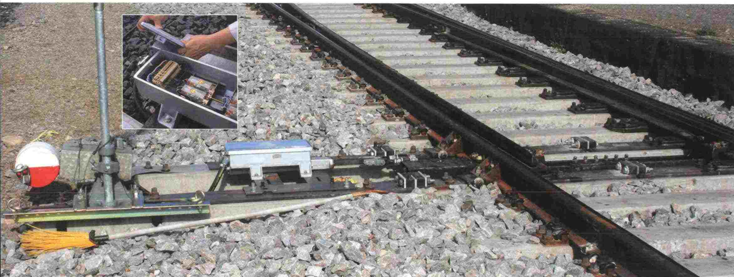
Vaihteenkosketin valvoo vaihteen oikeaa asentoa.
