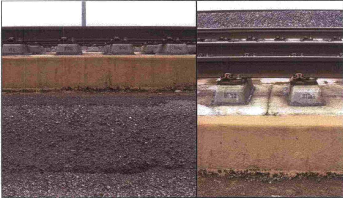
Kuva 1. Kiintoraiteen rakenne ja komponentit.
