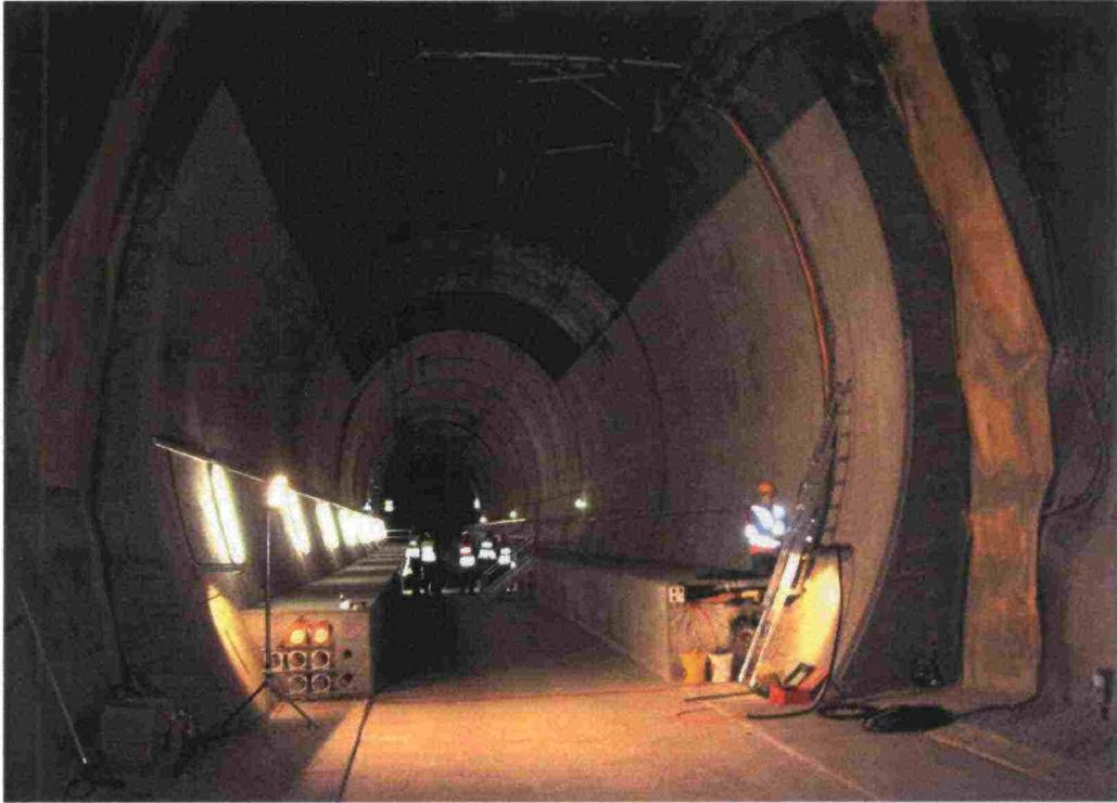
Kuva 6. Tunnelipoikkileikkauksen komponentit olivat esillä koerakentamisosuudella.
