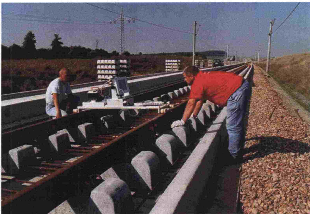
Kuva 20. Raidegeometrian mittaus ennen betonivalua (lähde: Pöyry Infra GmbH).
