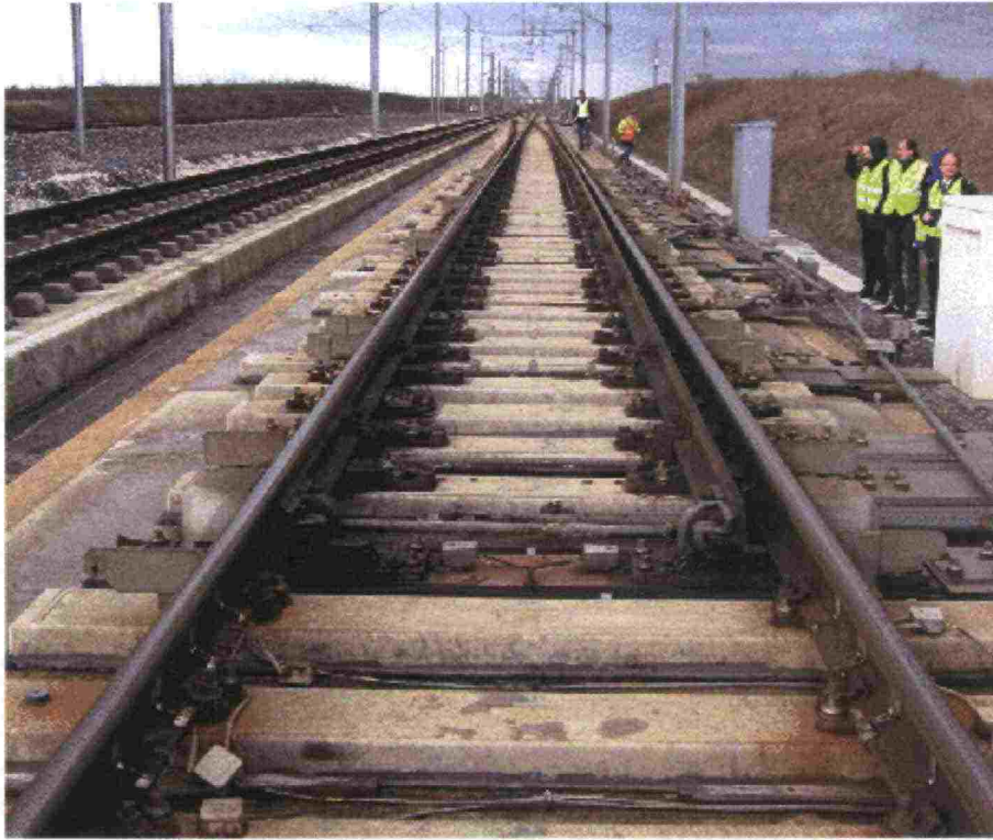
Kuva 2. Kiintoraideosuudelle asennettu 1:46 vaihde.
