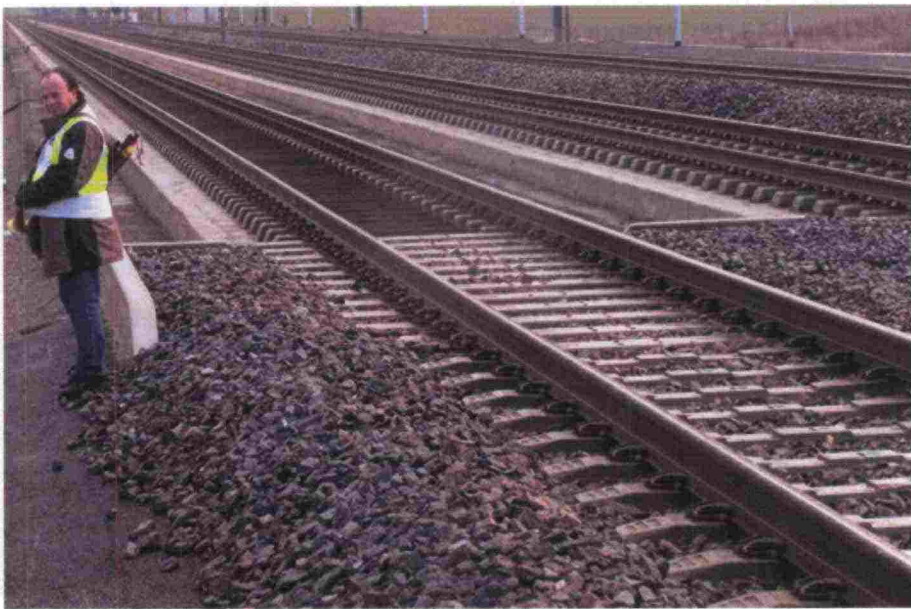
Kuva 4. Siirtymärakenne kiintoraiteelta sepeliradalle.
