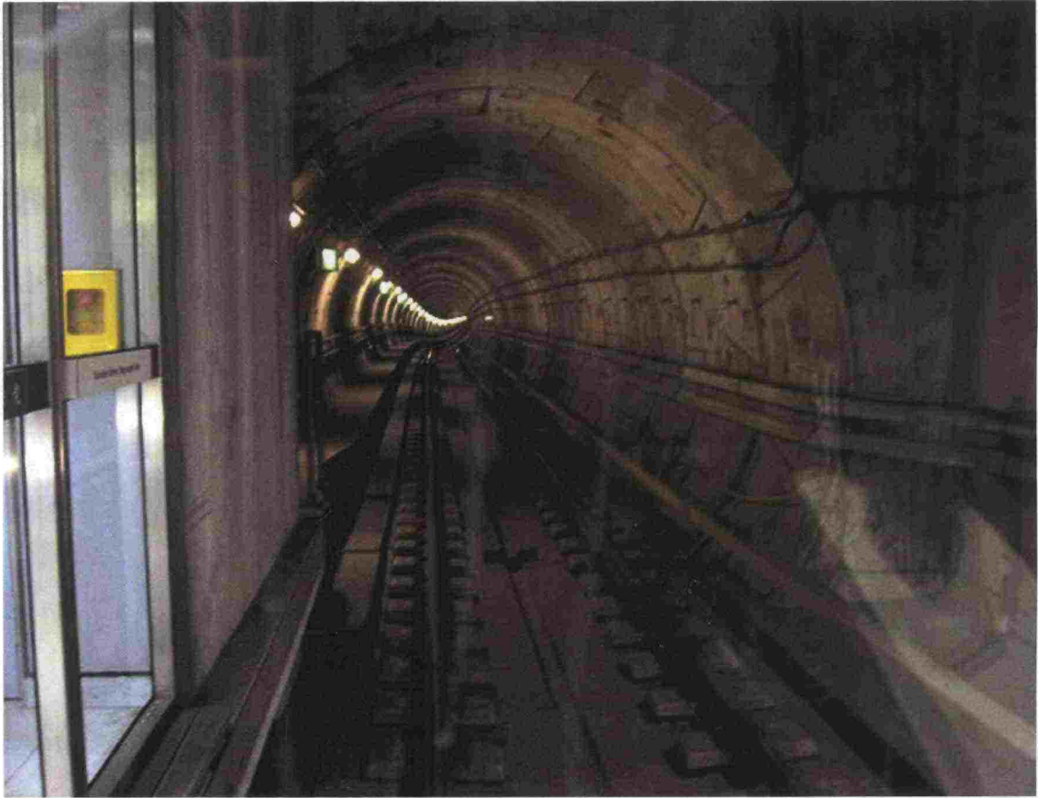
Kuva 12. Kööpenhaminan automaattimetron tunneliosuutta; sisähalkaisija vain 4,9 metriä.
