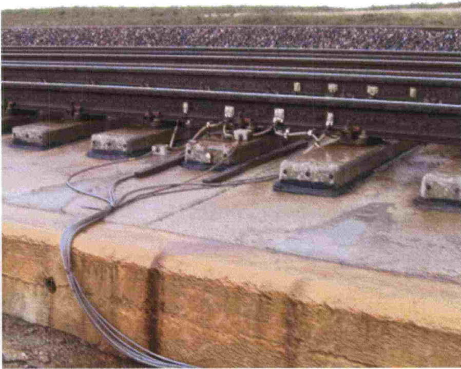
Kuva 3. Koekohde on varustettu laitteistolla, jolla seurataan rakenteen painumia eri olosuhteissa. Vasemmassa alakulmassa on veden poistoreikä ilmeisesti täyttövalun alueelle.
