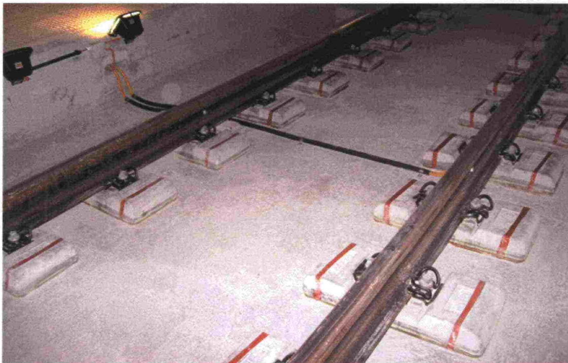
Kuva 11. Lötschbergin tunnelin koerakennesuudelle asennettu LVT-järjestelmään perustuva kiintoraiderakenne.
