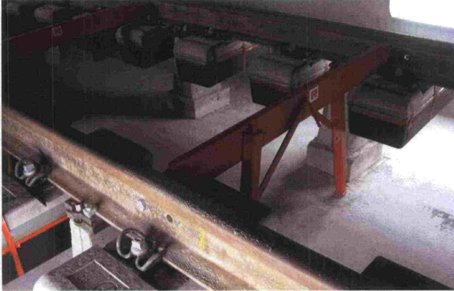
Kuva 7. Rhombergin käyttämä raiteen tukemismenetelmä sekä raidevälin varmistamiseen käytettävä tukirauta.
