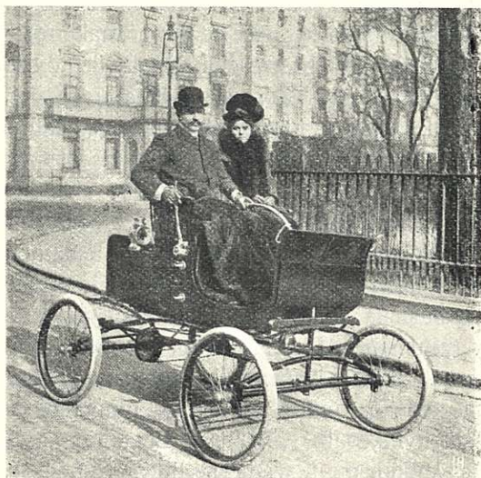
Kuva 5. Nestemäisellä ilmalla käytettävä voimavaunu. Se ei aiheuta yhtään kolinaa eikä hajua.
