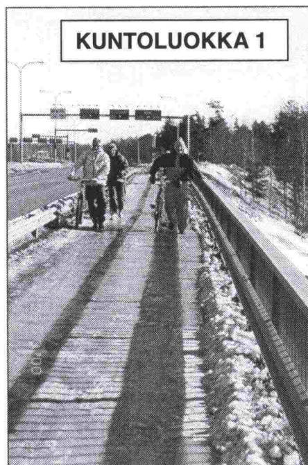
Kuva 44. Pohjantien ongelmallinen ylikulku (kohde 4).
