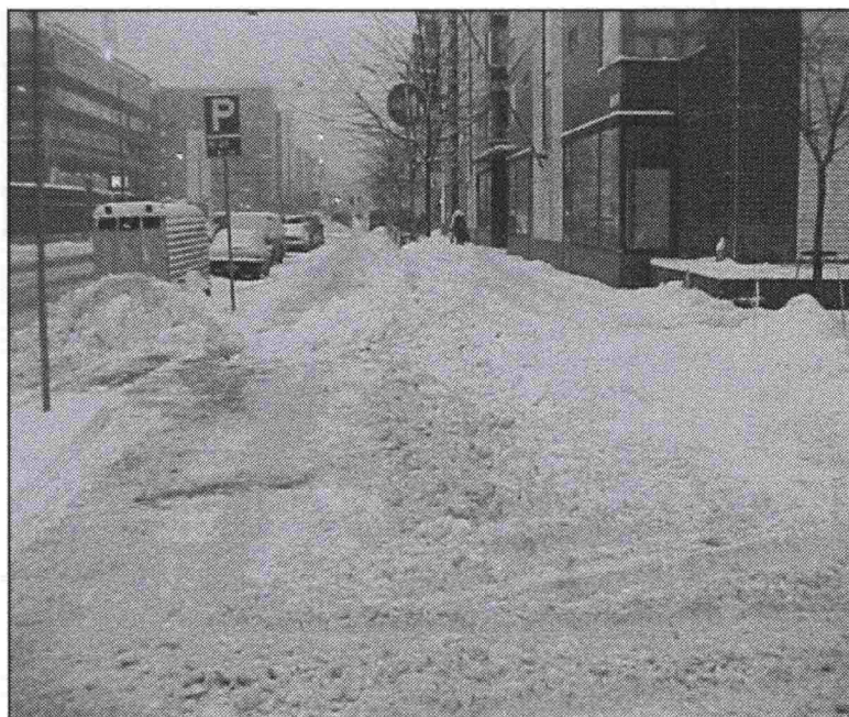
Kuva 17 Aurausjärjestelyissä on toivomisen varaa, pyörätie on aurattu, jalankulkukäytävä ei. Lunta on lisäksi jostain pukattu auratulle pyörätielle. Helsinki, Itämerenkatu 20.1.2000
