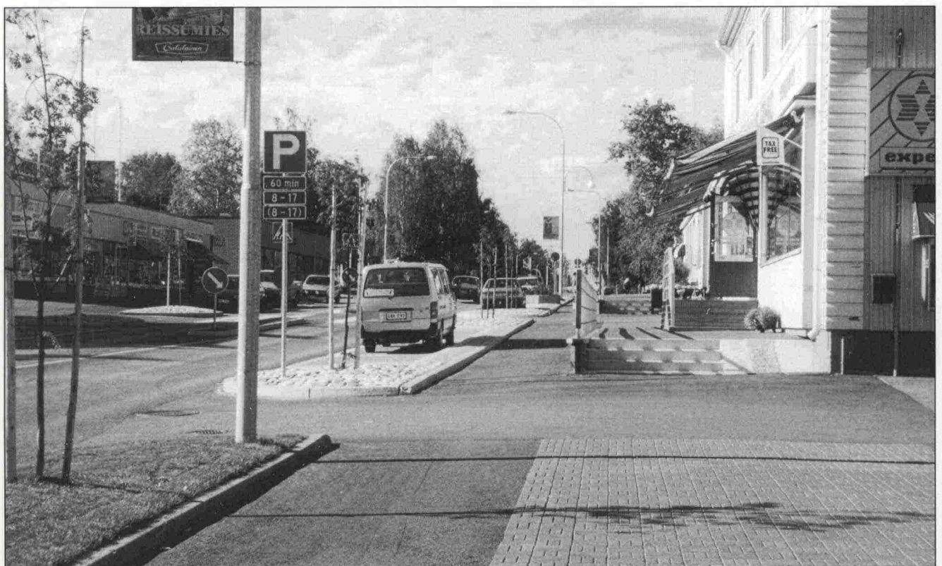
Kuva 3/4. Kainuuntien kauppakatujaossa nykytilanteessa. Joissakin kohdissa jalkakäytävälle on jouduttu rakentamaan portaat liikkeiden sisäänkäyntien korkeusasemien vuoksi.
