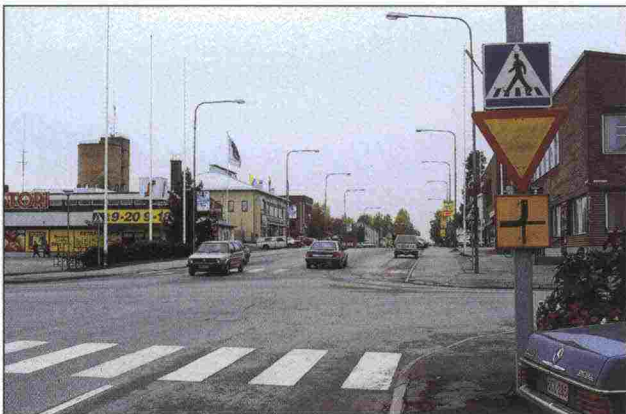
Kuva 4/13. Kainuuntien ja Koulukadun risteyksessä taajamatien ajosuunta muuttuu. Suunnanmuutosta on korostettu ajoradassa materiaalivaihdoksella, jota ei huomaa. Portaalit ovat maantiemäisiä.
