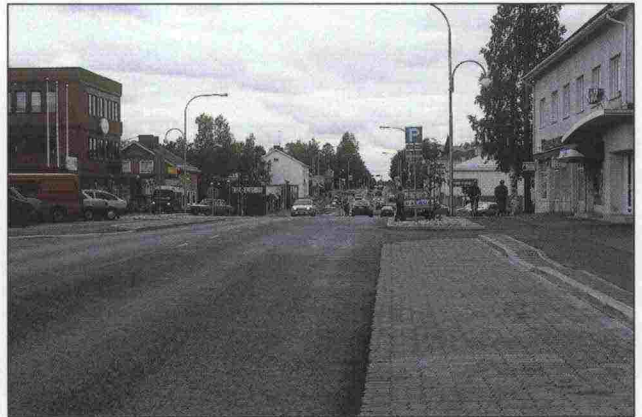
Kuva 4/22. Tienvarsipysäköinti on ohjattu taskuihin ja vino pysäköinti on ohjattu erilliselle pysäköintikaistalle.
