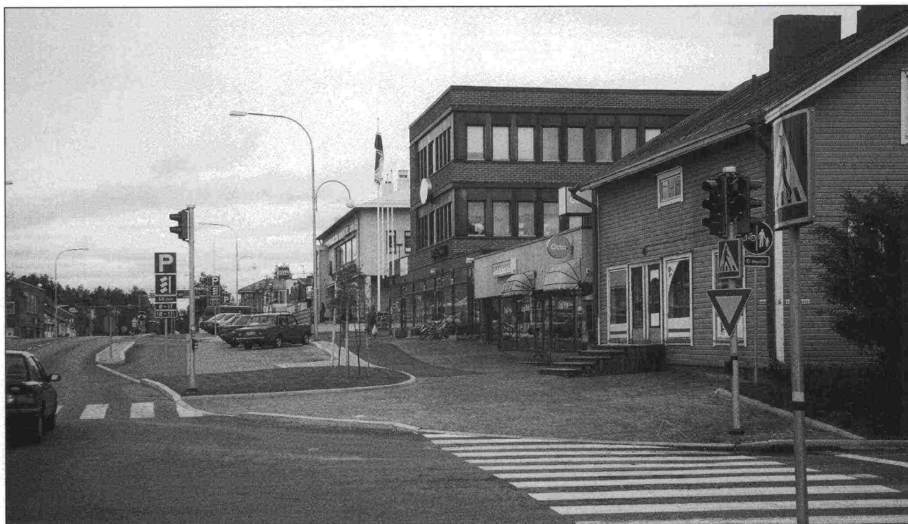
Kuva 4/20. Erillinen pysäköintikaista on erotettu reunakivillä ja korokkeella varsinaisesta tiestä.
