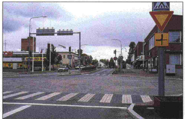
Kuva 4/13. Kainuuntien ja Koulukadun risteyksessä taajamatien ajosuunta muuttuu. Suunnanmuutosta on korostettu ajoradassa materiaalivaihdoksella, jota ei huomaa. Portaalit ovat maantiemäisiä.
