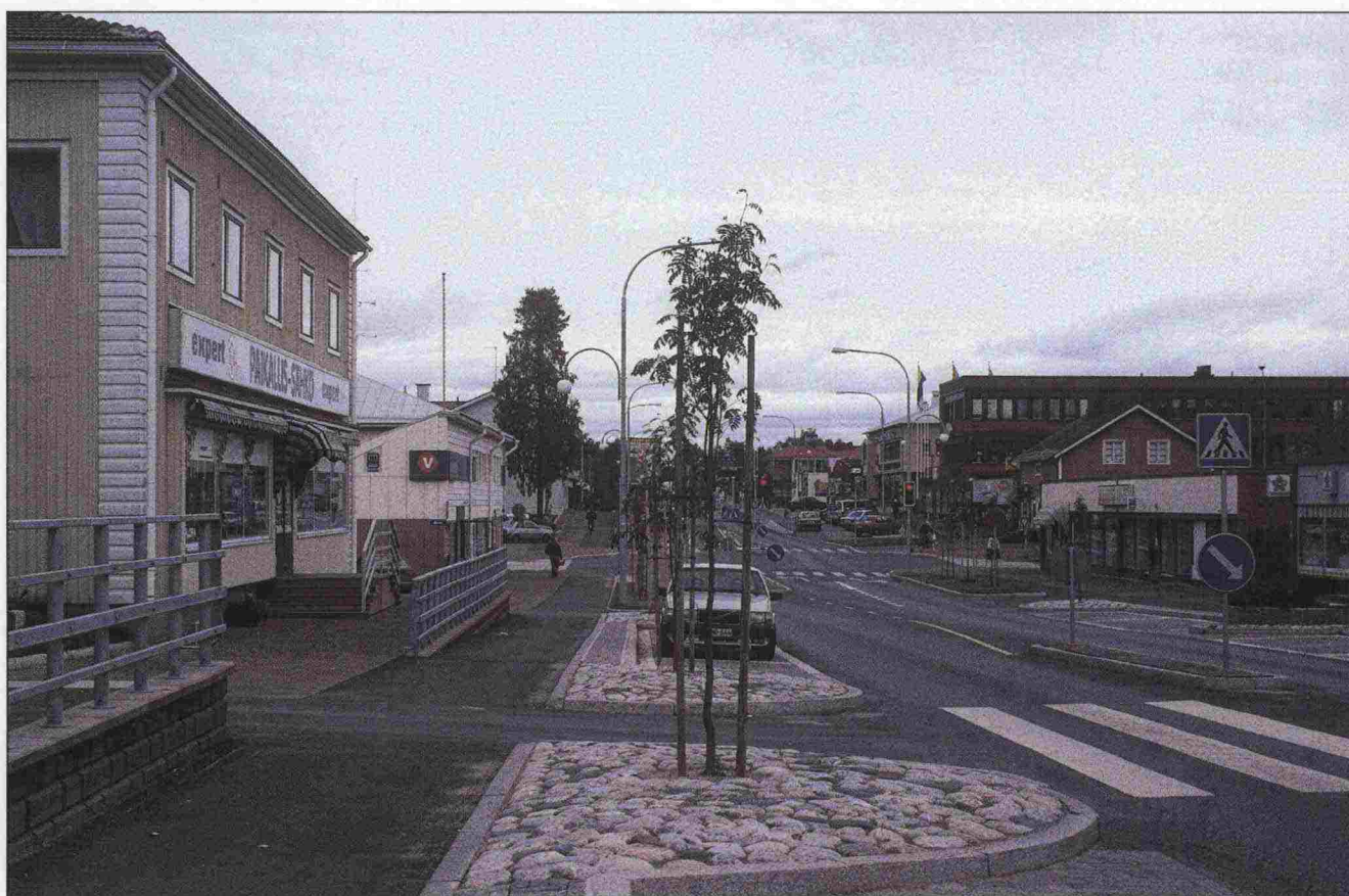
Kuva 4/32. Kainuuntien kauppakatujaoksella yhtenäiset fasadirivistöt ovat selkeä tausta, joka kestää voimakkaankin tien käsittelyn. Kevytiliikenteen tasaus ei kuitenkaan ole onnistunut.
