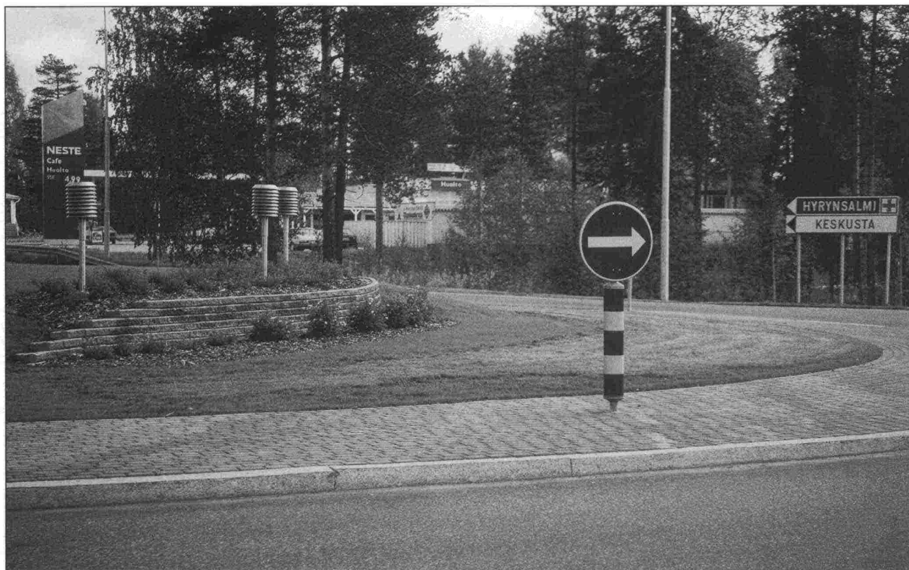
Kuva 4/18. Kiertoliittymässä on käytetty matalia pihavalaisimia.
