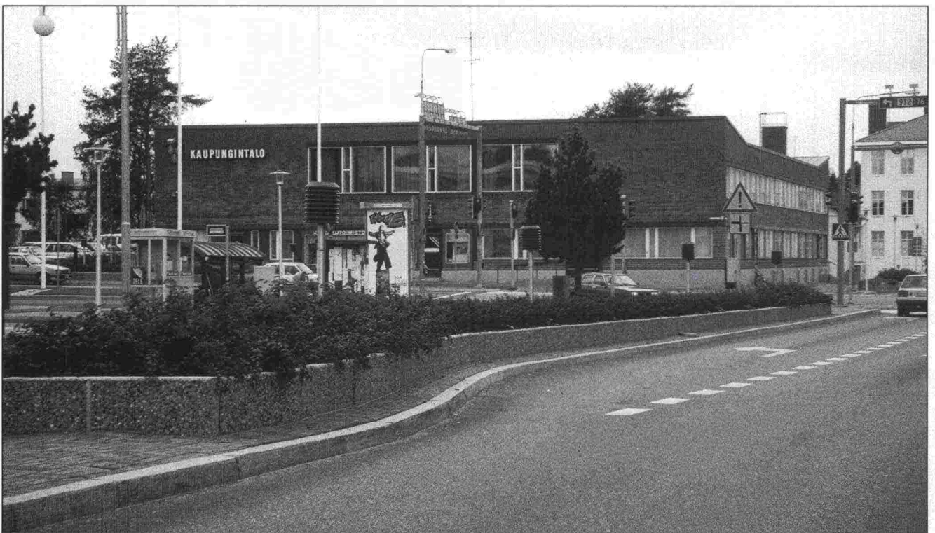
Kuva 4/19. Torin ympäristössä on korotettuja istutusaltaita. Istutusaltaat ovat betonielementtirakenteisia. Ne katkaisevat voimakkaasti poikittaisen katutilan. Istutusaltaissa on kasveina käytetty kesäkukkia ja erilaisia angervoja.
