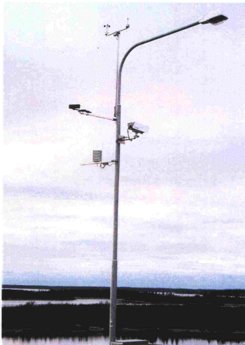
Kuva 2 Raippaluodon sillan sääasema ja kelikamera.
