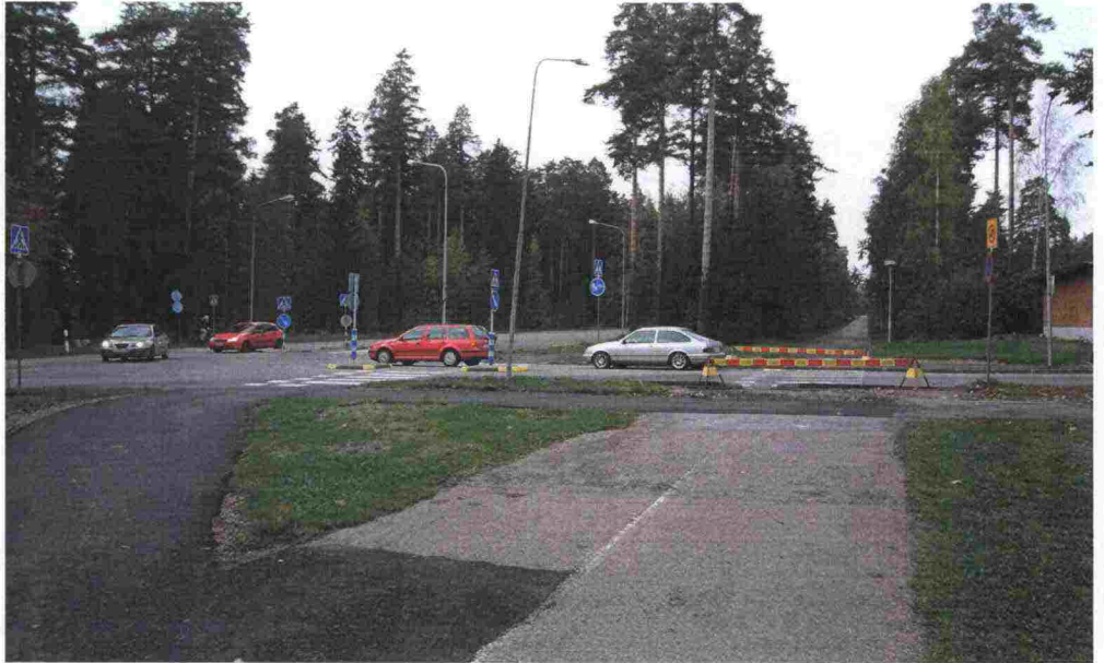
Kuva 31. Suojatie siirretty lähemmäksi liittymää (Kevätkummuntie/ Sammontie liittymä)
