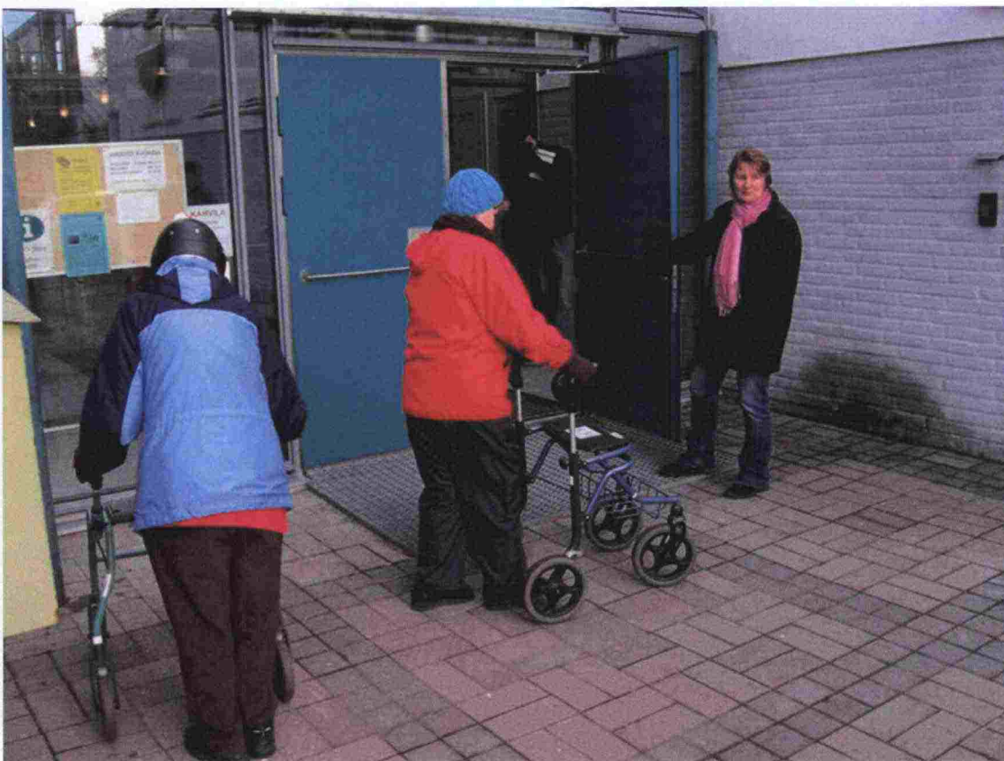
Kunnantalon ovet eivät avaudu automaattisesti.
