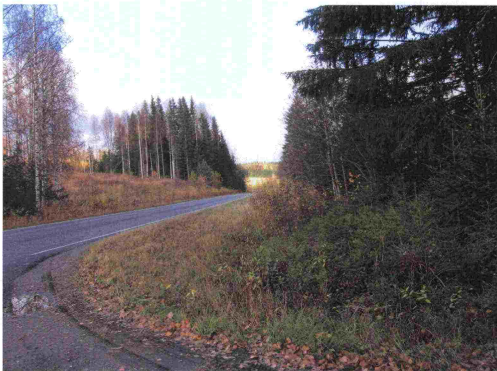
Kuva 30. Maantiellä 5640 olevassa Rampsuntien liittymässä vesakko peittää näkemää lisalmen suuntaan.
