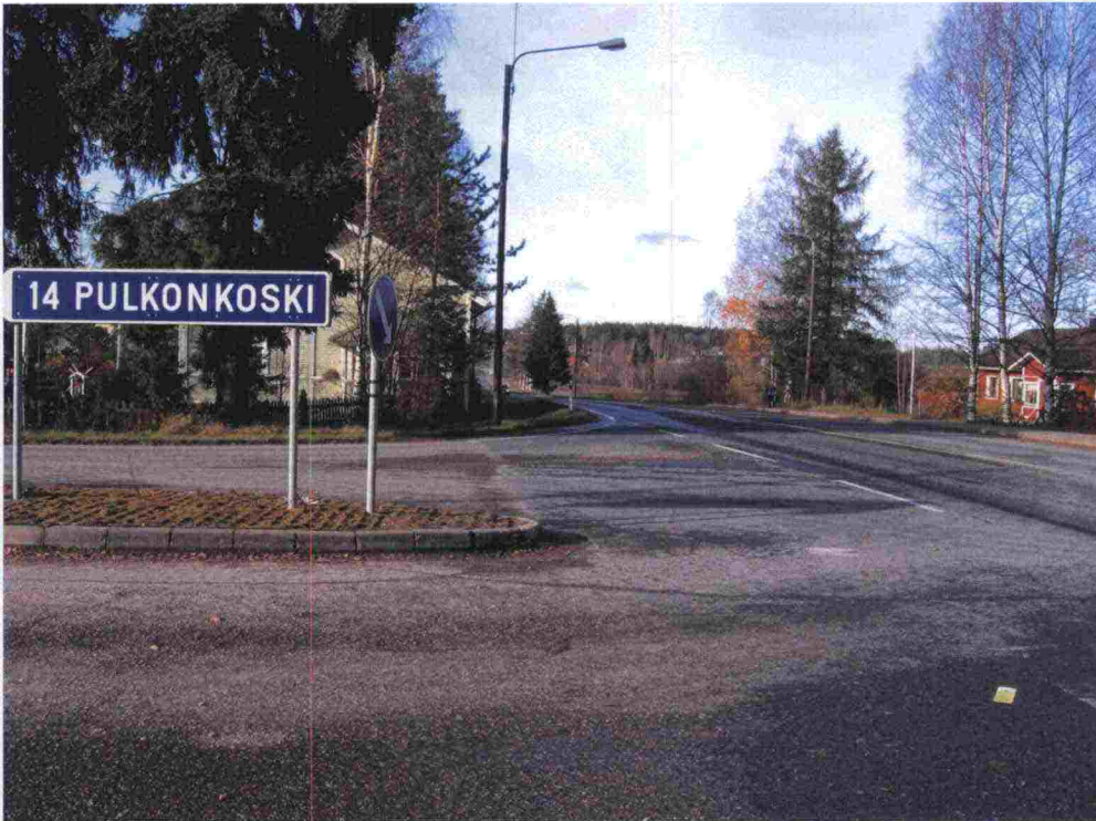
Kuva 31. Kantatiellä 77 on näkemä Maaningan suuntaan maantien 5571 liittymässä huono johtuen läheisestä rakennuksesta ja valopylvästä.
