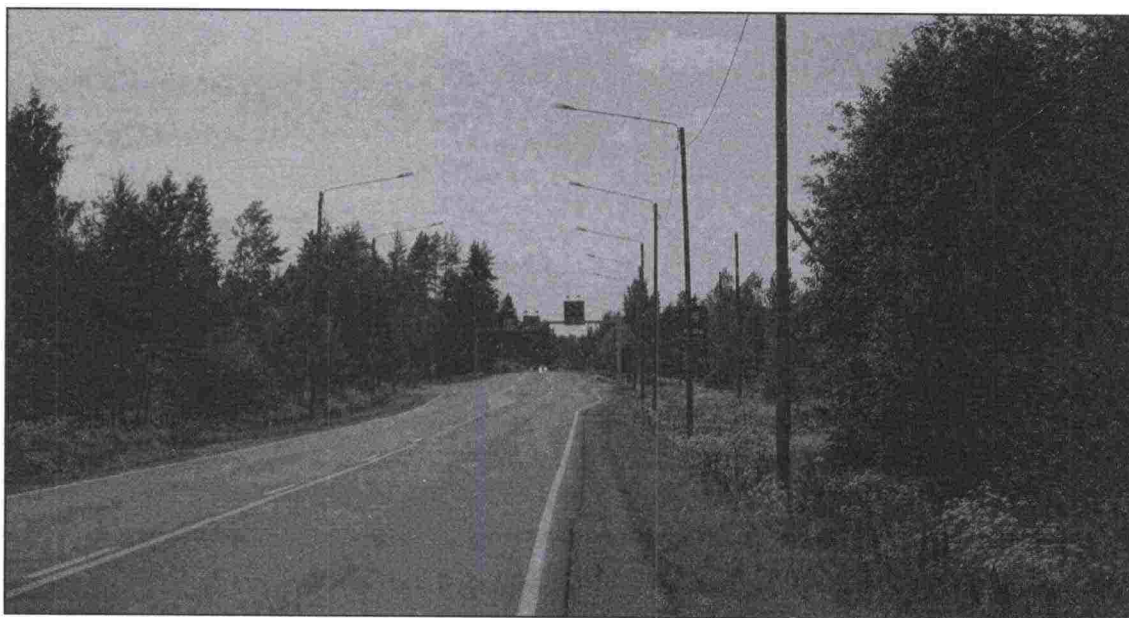
Kuva 6. Ullan liittymässä on yleisen tieverkon osalta tapahtunut eniten onnettomuuksia.
