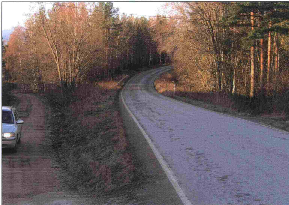
Kuva 4.8. Nykyinen epävirallinen itäinen Soskuantien liittymä idästä kuvattuna. Uusi liittymä esitetään toteutettavaksi kuvassa näkyvälle nykyisen liittymän länsipuolelle.
