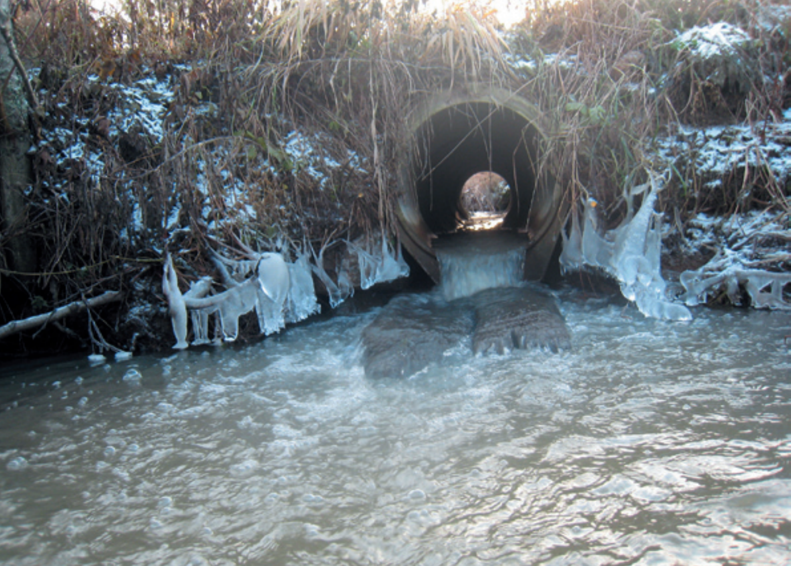
Kuva 10. Pantojassa sijaitseva tierumpu on vesistössä esiintyvälle taimenelle täydellinen nousueste. Kuva: Esko Vuorinen.
