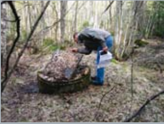
Kaivoksi muutettu lähde. Kuva: Aki Hassinen.
