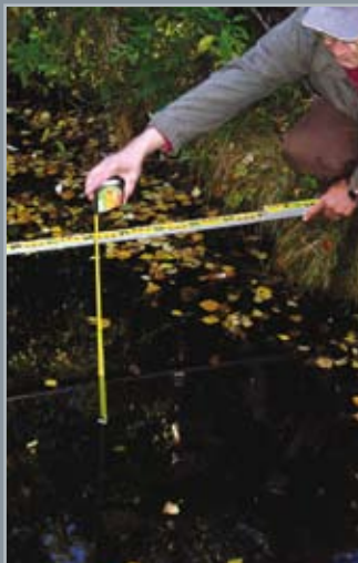
Kestävän padon rakentamisen eri vaiheita. Teroitetut paalut ja sammalmatot on tehty ensimmäiseksi. Latalla ja mittanauhalla mitataan tavoiteltu veden korkeus. Paalut upotetaan lekalla riittävän syvälle. Jotta pato olisi tiivis – vuorataan se suodatinmatalla, jonka päälle turvematot asetetaan. Kuvat: Seppo Kettunen.
