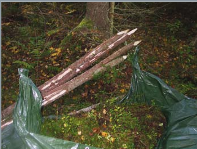
Kestävän padon rakentamisen eri vaiheita. Teroitetut paalut ja sammalmatot on tehty ensimmäiseksi. Latalla ja mittanauhalla mitataan tavoiteltu veden korkeus. Paalut upotetaan lekalla riittävän syvälle. Jotta pato olisi tiivis – vuorataan se suodatinmatalla, jonka päälle turvematot asetetaan. Kuvat: Seppo Kettunen.
