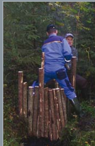
Kestävän padon rakentamisen eri vaiheita. Teroitetut paalut ja sammalmatot on tehty ensimmäiseksi. Latalla ja mittanauhalla mitataan tavoiteltu veden korkeus. Paalut upotetaan lekalla riittävän syvälle. Jotta pato olisi tiivis – vuorataan se suodatinmatalla, jonka päälle turvematot asetetaan. Kuvat: Seppo Kettunen.
