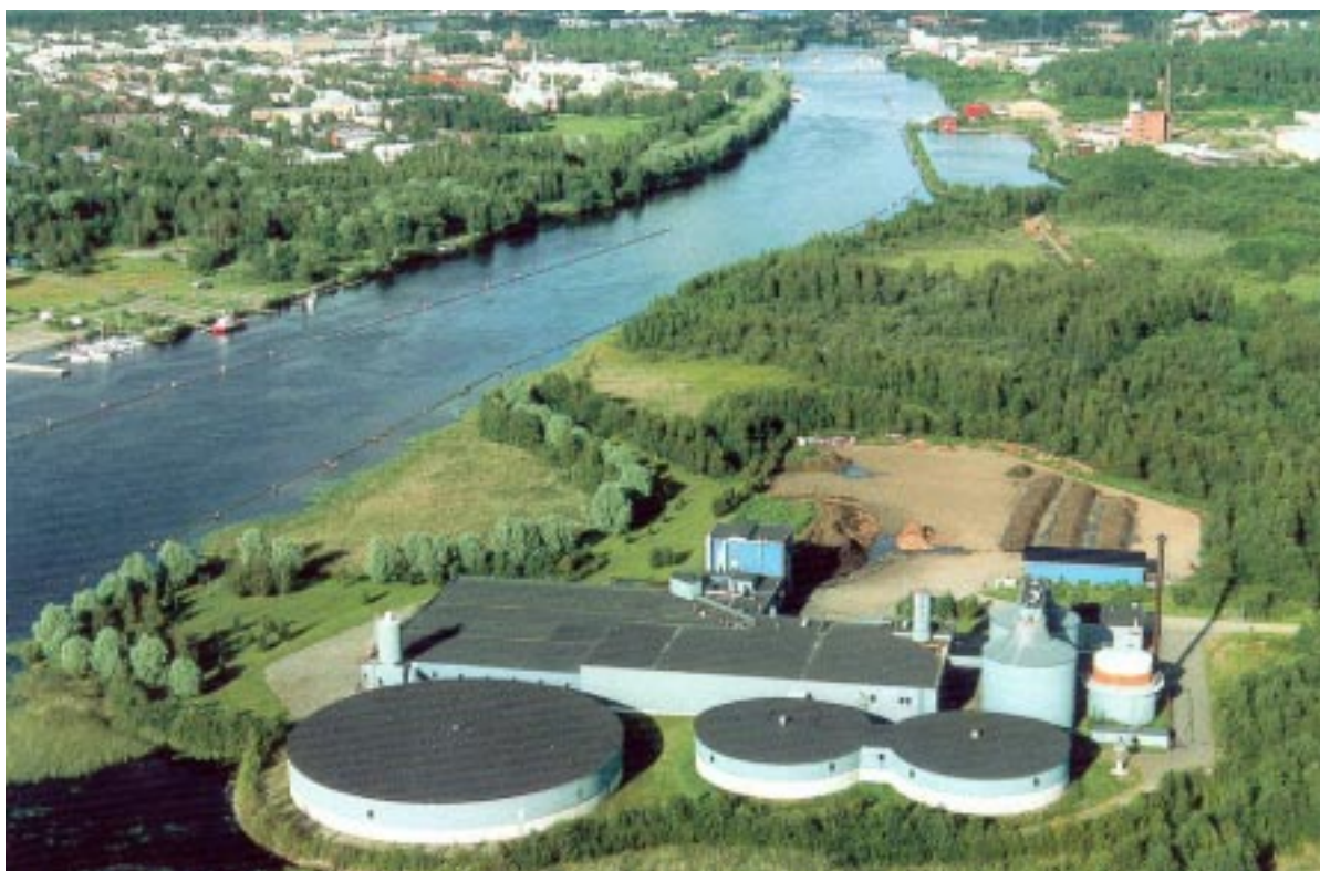
Kuhasalon jätevedenpuhdistamo, Joensuu. (Kuva: Joensuun kaupunki)
