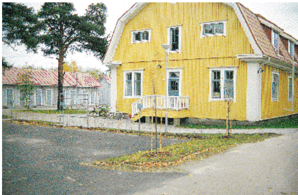
80 vuotta vanha hirsi-talo Korpela, Varkau- dessa. Korjattu ympä- ristökeskuksen rahoi- tuksella vuosina 1995- 1996
