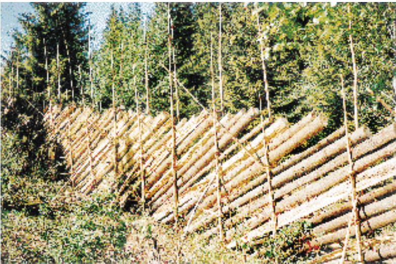
ja rakennettiin pisteaitaa
