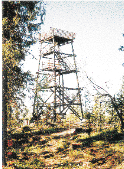
Väisälänmäen näkötorni rakennettiin vuonna 1996
