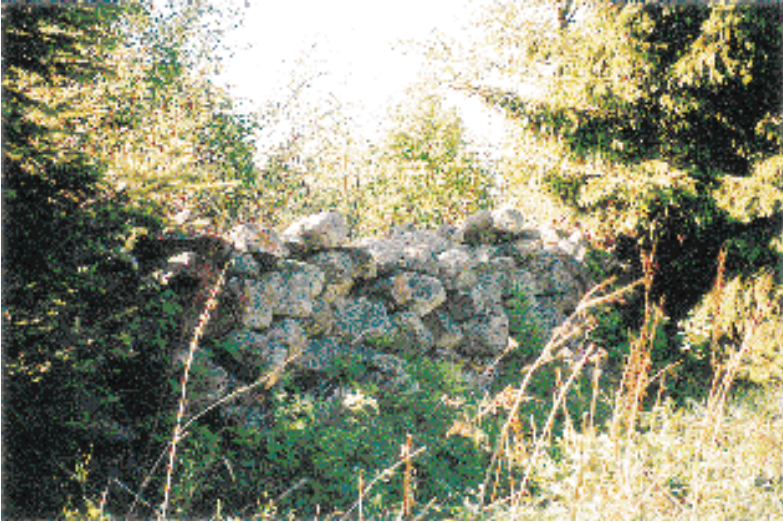
Väisälänmäellä korjattiin kivivaitoja
