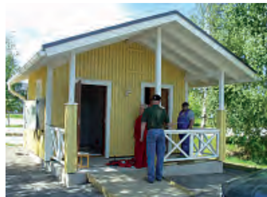
Lohitien wc-rakennuksen sisätyöt tehtiin valmiiksi ja se maalattiin. Työsuunnittelija Pertti Huttunen ja projektipäällikkö Pirjo Karinen käivät työntekijän kanssa läpi tehtyjä töitä.
