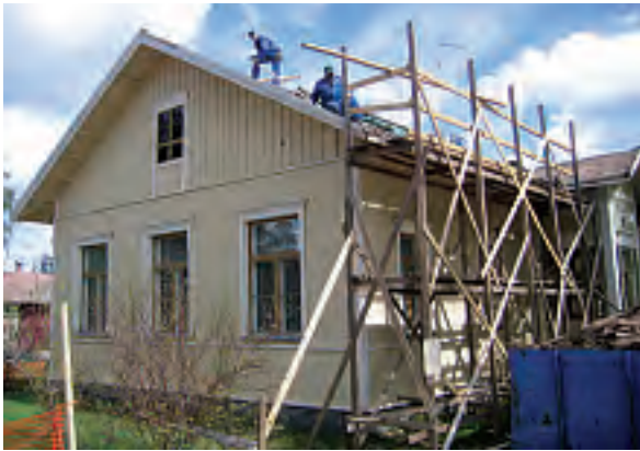
Tuovilanlahden koulun kattoremontti aloitettiin suunnitelmien mukaan. Talon ympärille rakennettiin suoja-aita ja puiset telineet. Vanha tiilikatto purettiin ja katon alta poistettiin vanhat päreet ja ruoteet.
