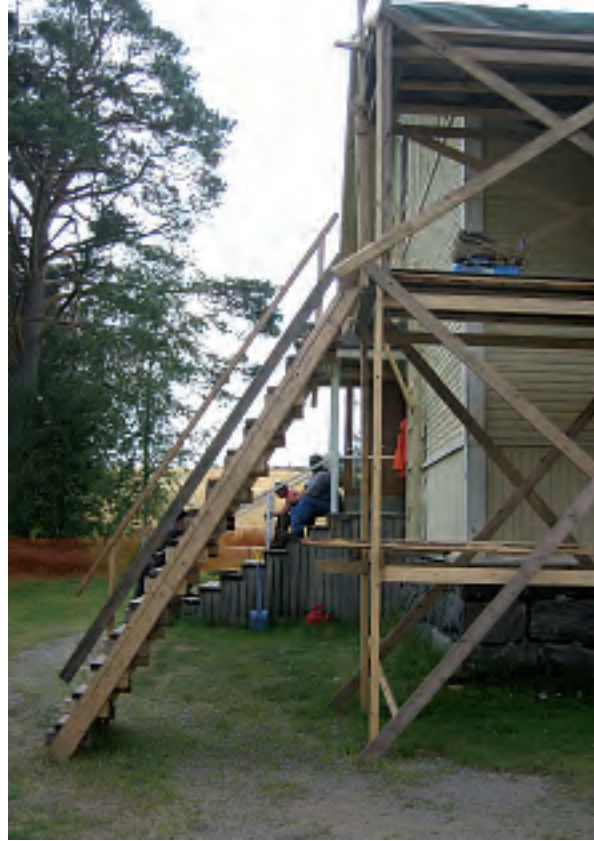
Tuovilanlahden koulun kattoremontti aloitettiin suunnitelmien mukaan. Talon ympärille rakennettiin suoja-aita ja puiset telineet. Vanha tiilikatto purettiin ja katon alta poistettiin vanhat päreet ja ruoteet.
