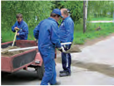
Työkaudella paikattiin myös tievaurioita.
