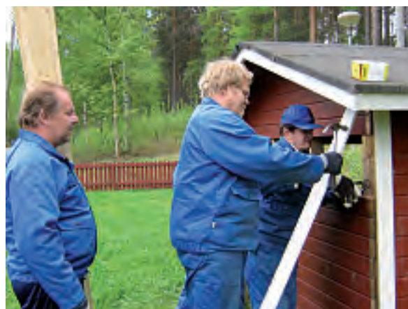
Leikkimökki kunnostettiin vaihtamalla laudoituksesta huonoksi menneitä uusiin.
