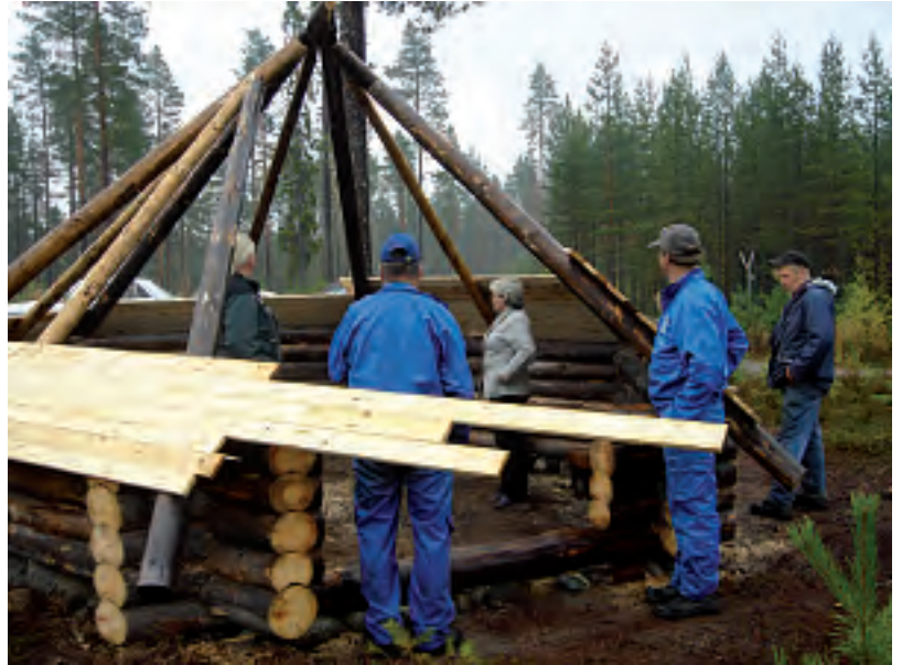
Työsuunnittelija Reijo Kärki ja lisälmen työntekijät esittelevät projektipäällikkö Pirjo Kariselle kotilaavun katon rakennustyön vaiheita.
