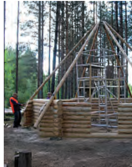
Katon pystypuiden asettaminen kohdalleen oli tarkkaa työtä.
