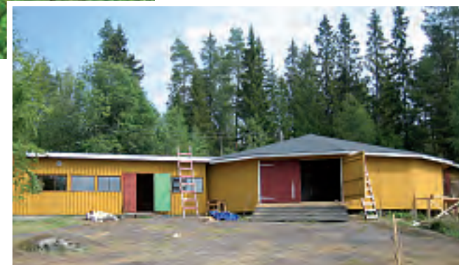
Vesannon Asinsalmen tanssilavan kunnostus tehtiin suunnitelmien mukaan. Katto tuettiin ja oikaistiin. Lavan ulkovuoraus uusittiin ja maalattiin keltamultamaalilla. Uusi lippukoju rakennettiin vanhan tilalle.
