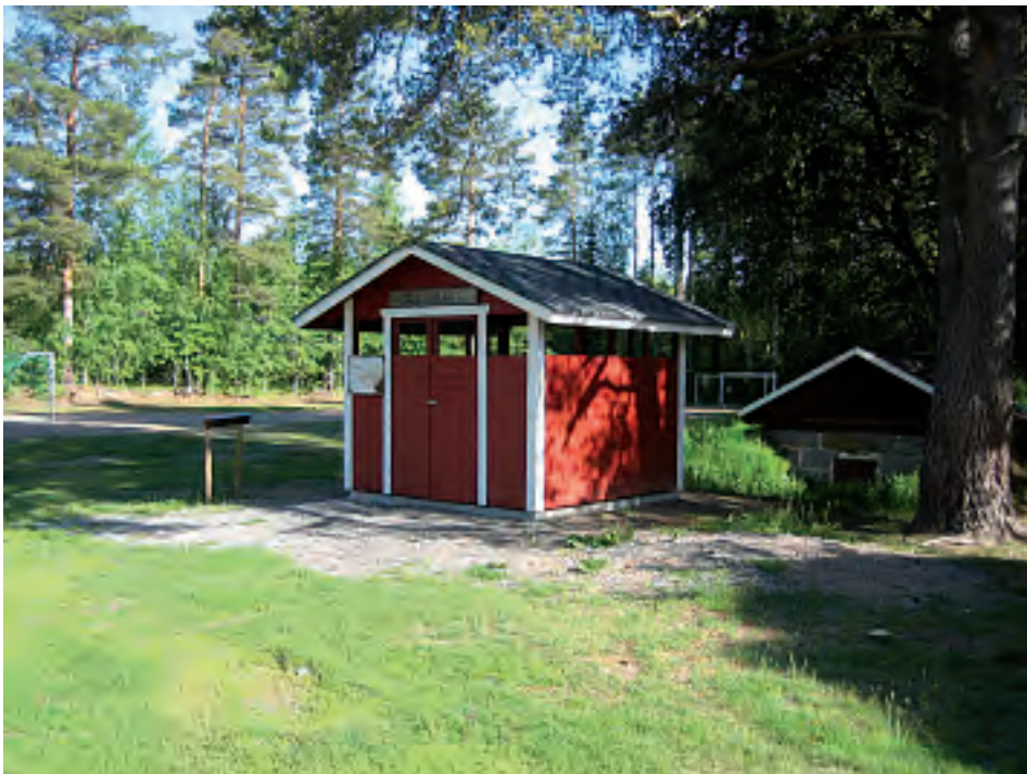
Maaningalla rakennettiin jätekatoksia. Kuvassa oleva jätekatos sijaitsee Tuovilanlahden koululla.
