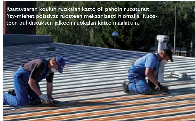
Metsäkartanolla jatkettiin rakennusten julkisivujen tervauusta. Samalla kunnostettiin vuorilautoja ja uusittiin ja maalattiin räystäslautoja sekä tehtiin uusia portaita.
