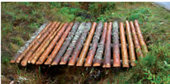
Rautavaaralla tulvat olivat vieneet siltoja vaellusreiteiltä. Siltoja ja kansia tehtiin myös moottorikelkkareitille.
