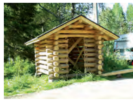
Koirakoskelle siirrettiin Sonkajärven kunnan varikolla tehty halkoliiteri. Liiteri tuettiin siirtoa varten laudoituksella.
