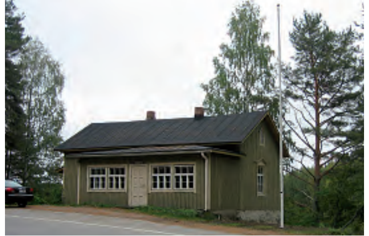
Museon kattoon laitettiin uusi rimahuopa. Museon sivustalla oleva lipputanko ei puiden peitosta ennen näkynyt.
