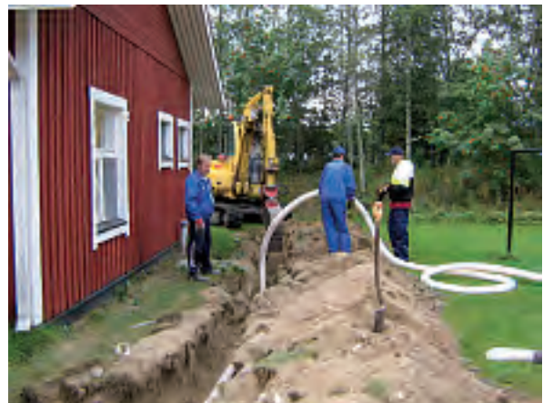
Kerkonkosken vuokrataloille valmistuu uusi salaojitus.
