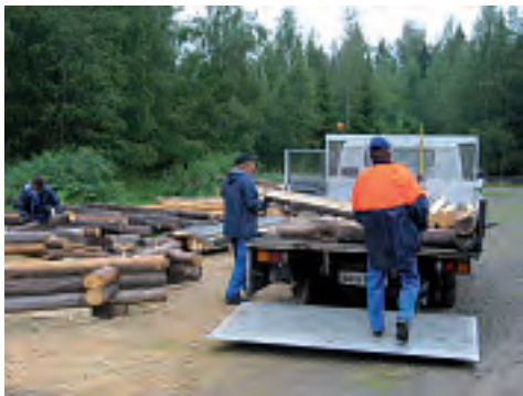
Ohenmäkeen siirrettävä kotilaavun hirsikehikko veistettiin Hanhilammella.
