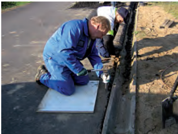
Hoitokoti Pauliinan pihalle asennetaan betonikourua.
