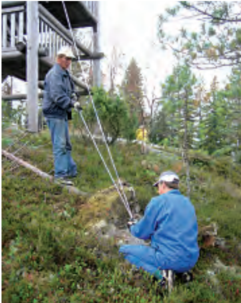
Kiparin näköalatornin huojumista estämään asennettiin haarukset, jotka porattiin kiinni kallioon.
