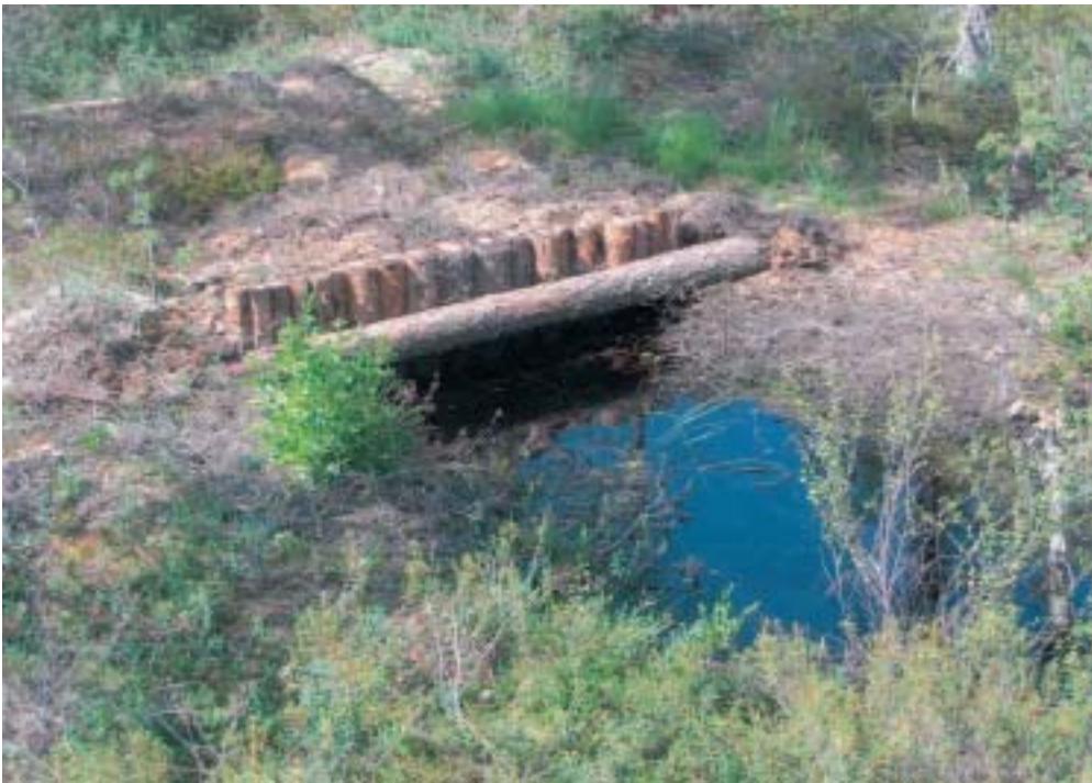
Kuva 35. Ätäskön valuma-alueen kunnostuksessa mm. tukitaan tarpeetomia oja ja tehdään pintavalutuskenttiä. (Kuva: Helge Rummukainen)
