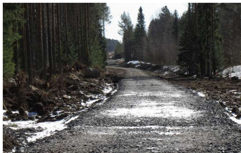
Oulussa Hiukkavaaran alueen ja Poikkimaantien rakentamiseen liittyen tehdään uusia kevyenliikenteen väyliä mt 8300:n varrelle.
