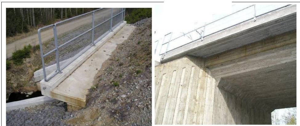
Kuva 11. Teräsbetonisia levennysrakenteita
