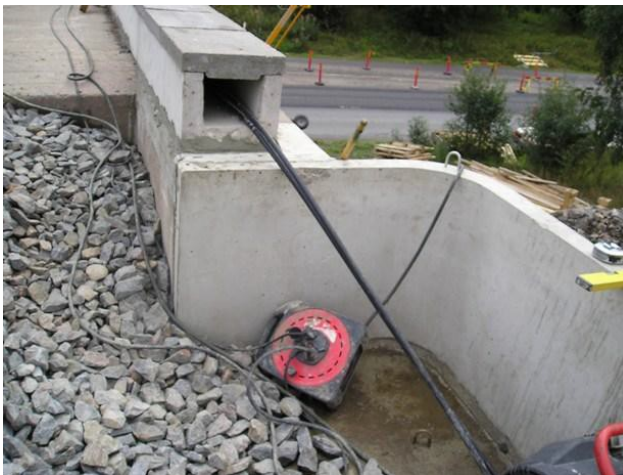
Kuva 12. Kulmatukimuurielementin asennustyö
