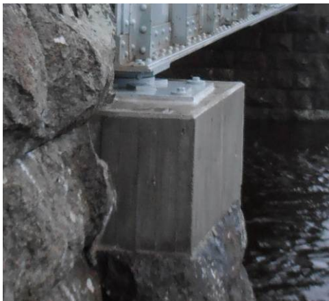
Kuva 8. Uusittu laakeripalkki ja laakeri
