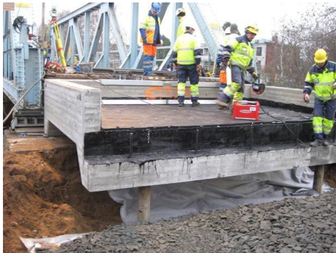
Kuva 13. Sillan tulopenkereen vahvistaminen kantavalla teräsbetonisella elementtirakenteella.
