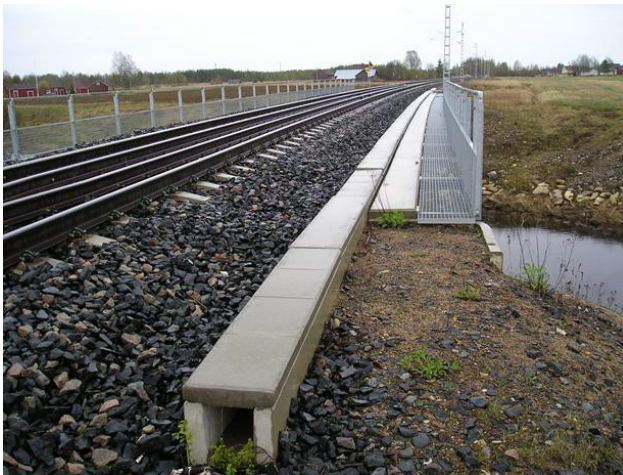
Kuva 5. Rautatiesillan huoltokäytävä ja sen jatkaminen penkereellä
