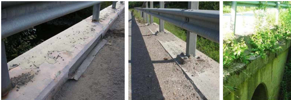
Kuva 12. Pinnoiteriekaleita, hiekkaa ja kasvillisuutta reunapalkilla.
