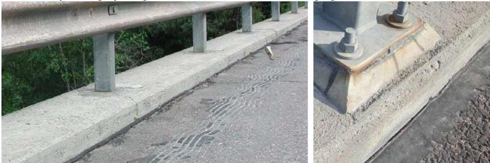
Kuva 8. Reunapalkin ja päällysteen välinen sauma on puhdas ja kunnossa.
