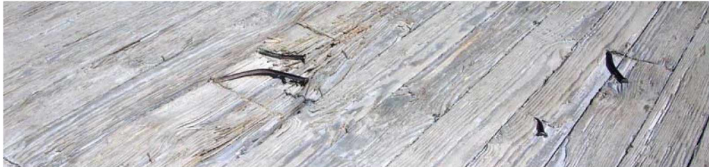
Kuva 32. Poistettavia nauloja puukannessa.
