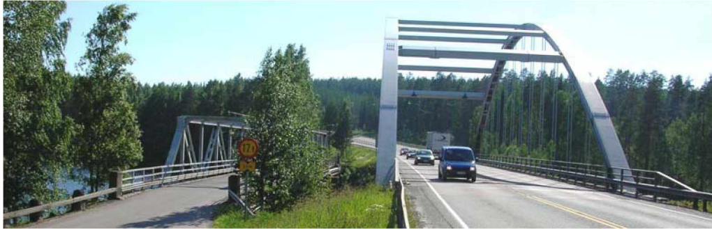
Kuva 11. Ristikkosilta ja Langer-palkkisilta.
