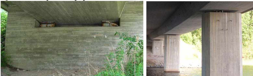
Kuva 3. Laakeritasoilla ei ole kasvillisuutta, irtainesta tai roskaa (siltä etäisyydeltä nähtynä kuin vuositarkastuksen yhteydessä on mahdollista).
