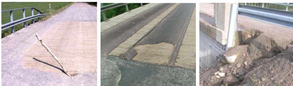
Kuva 33. Liikennettä vaarantavia, välittömän reagoinnin vaativia kulutuskerros- ja päällystevaurioita.
