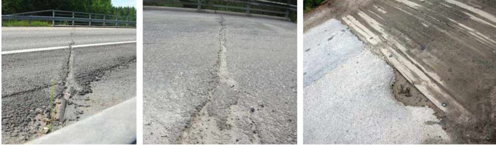
Kuva 18. Puhdistettavia sillan pään saumoja.
