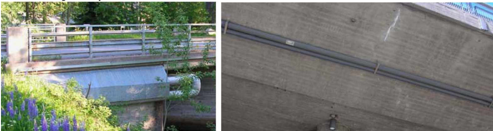
Kuva 18. Kaapelit, putket, johdot sekä niiden suojapellit ja kiinnitykset ovat kunnossa. Kyseisten varusteiden hoito kuuluu niiden omistajille, mutta hoitourakoitsijalla on velvollisuus ilmoittaa tilaajalle havaitsemistaan puutteista ja vaurioista.
