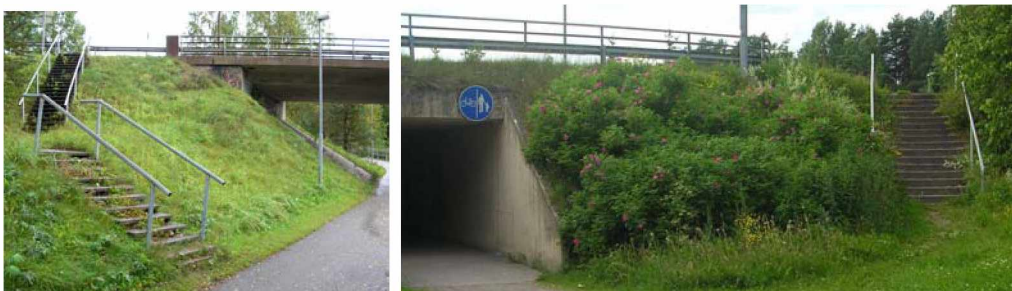
Kuva 31. Kasvillisuuden valtaamia siltapaikan portaita.
