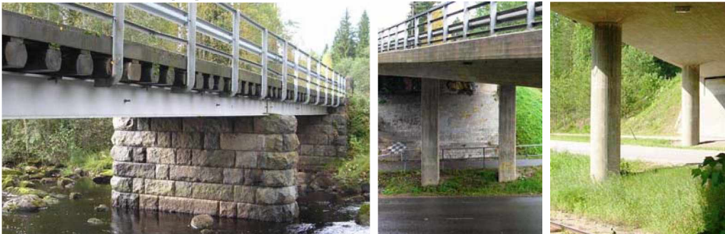
Kuva 2. Välituet ovat puhtaat maa-aineksista ja kasvillisuudesta. Risteysiltojen välitukien juurella ei ole ylimääräisiä maa-aineksia.
