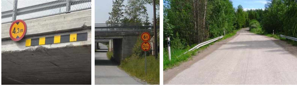
Kuva 19. Siltaan liittyvät liikennemerkkit ovat puhtaat ja kunnossa.
