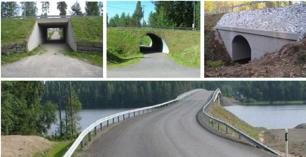
Kuva 23. Tien sisäluiskat ovat kunnossa. Luiskassa ei ole vesakkoa eikä puustoa eikä tieltä poistuneen veden aiheuttamaa eroosiota eikä muitakaan purkautumia. Pengerkaiteiden alla ei ole palteita. Ylärivissä vasemmalla hoitourakoitsijalla on vielä alittava väylä siistimättä niiton jäljiltä.
