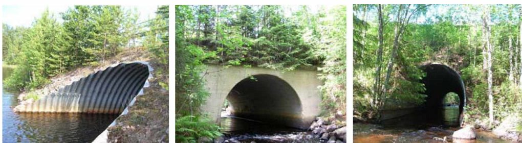
Kuva 29. Vesakko ja puusto raivaamatta tien sisäluiskasta siltapaikalla.
