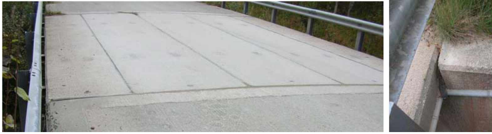
Kuva 16. Sillan betonisten rakenneosien välisiä saumoja, joiden puhdistuksessa noudatetaan samaa ohjeistusta kuin reunapalkin liikuntasauaman puhdistuksessa.
