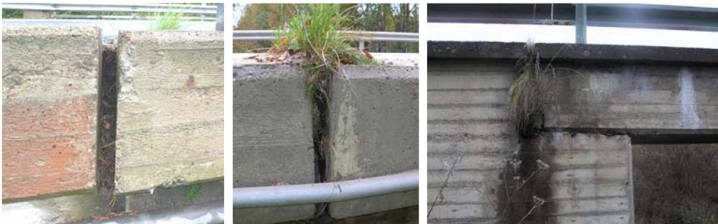
Kuva 15. Puhdistamattomia reunapalkin ja reunakaistan liikuntasäuroja.
