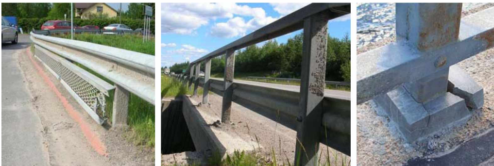
Kuva 19. Pesemättömiä kaiteita sekä lohjennut juurikorokkeen kappale, joka on poistettava ennen kaiteiden pesua.
