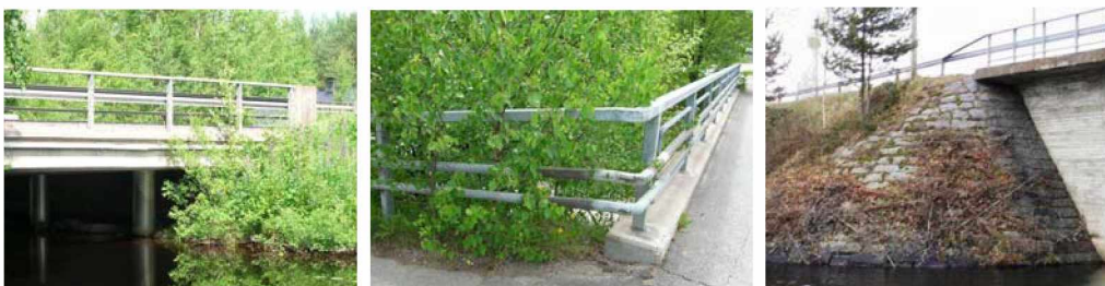
Kuva 27. Keilan vesakko kaatamatta tai kuljettamatta pois.
