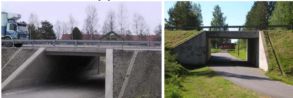
Kuva 20. Kuivatuslaitteet ovat puhtaat ja kunnossa. Vesi ei jää seisomaan sillalle eikä alittavalle väylälle vaan pääsee esteettä hulevesikaivoon.
