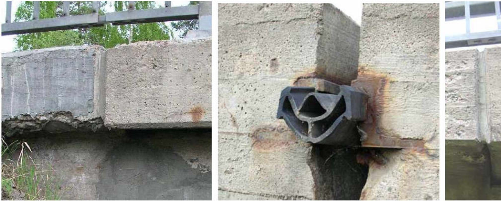
Kuva 7. Reunapalkin liikuntasaumamat ovat puhtaat, ehjät ja vesitiiviit.
