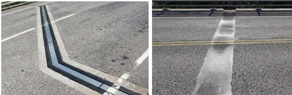
Kuva 12. Liikuntasaumalaitteet ovat puhtaat eli hoidon näkökulmasta kunnossa.
