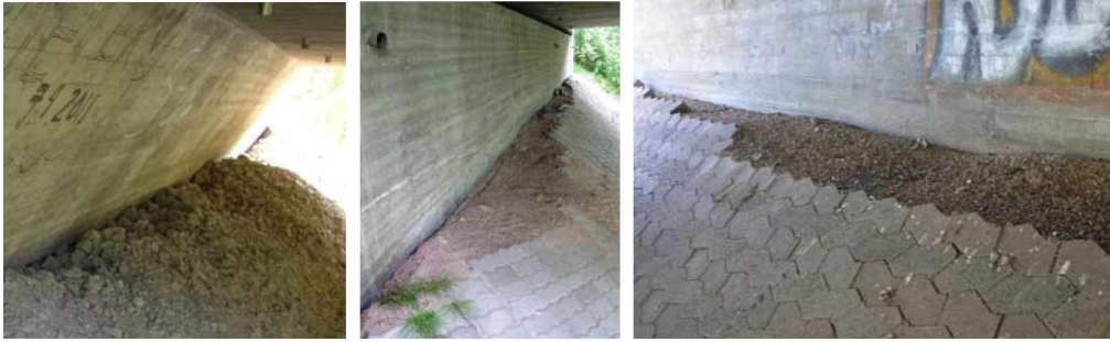
Kuva 47. Hoitourakoitsijan kunnostusvastuuseen kuuluvia alle 2 m 2 :n suuruisia etuluiskan purkautumia.
