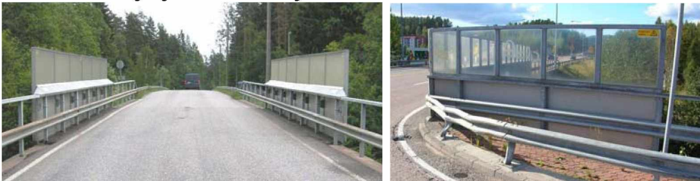
Kuva 16. Kosketussuojaseinät ovat kunnossa. Hoitourakoitsijan kunnostusvastuuseen kuuluvat kosketussuojaseinän alaosan peltien ja suojalevyjen sekä nousuesteen kiinnitykset. Yläosa plekseineen kuuluu radan kunnossapitäjän vastuuseen.
