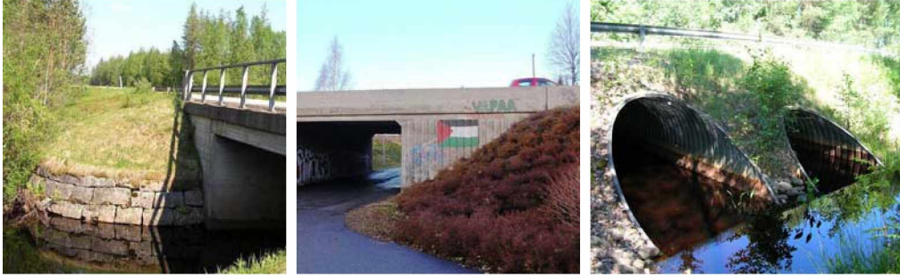
Kuva 22. Keilat hyvin hoidettu. Alikulkukäytävän pensaat ovat sillan ympäristösuunnitelmaan kuuluvia istutuksia, joita ei saa raivata pois. Pienessä uomassa ei ole veden virtausta tukkivaa vesakkoa.
