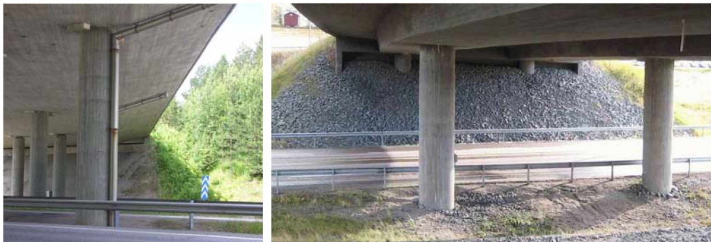
Kuva 7. Välitukeen kiinnitetty syöksytorvi pestään välituen pesun yhteydessä, hiekka ja maa-ainekset poistetaan ympäröivän maanpinnan tasoon välituen juurelta.
