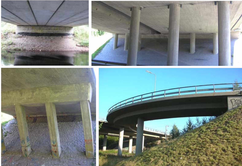
Kuva 21. Etuluiskat ovat kunnossa, niissä ei ole purkautumia, vesakkoa eikä puustoa. Kivetyt etuluiskat ovat heinittymättömät. Maasto sillan alapuolella ei kasva vesakkoa eikä puustoa.
