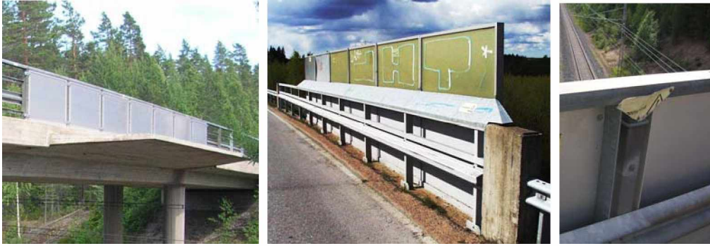
Kuva 44. Vasemmanpuoleisessa sillassa hoitourakoitsijan kunnostusvastuuseen kuuluu koko pystysuora osuus pelteineen ja suojalevyineen. Vaakasuoja kosketuslippa kuuluu radan kunnossapitäjän kunnostusvastuuseen. Keskimmaisessä sillassa hoitourakoitsijan vastuuseen kuuluvat nousuesteen kiinnitysten korjaamisen lisäksi kaiteiden sisäpuolelta tehtävät kosketussuojaseinän alaosan suojapeltien ja -levyjen kiinnitysten korjaukset. Oikeanpuoleisessa tapauksessa hoitourakoitsijan on ilmoitettava hajonneesta hengenvaara-kyllistä viipymättä rataisännöitsijälle.
