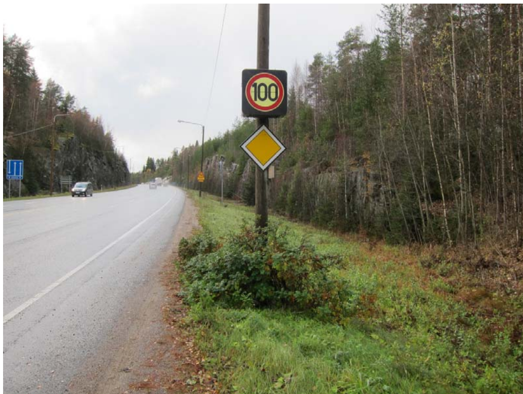
Kuva 25. Yleiskuva kallioleikkauspaikasta valtatiellä 9. Tarkastettu osuus on kuvassa oikealla.
