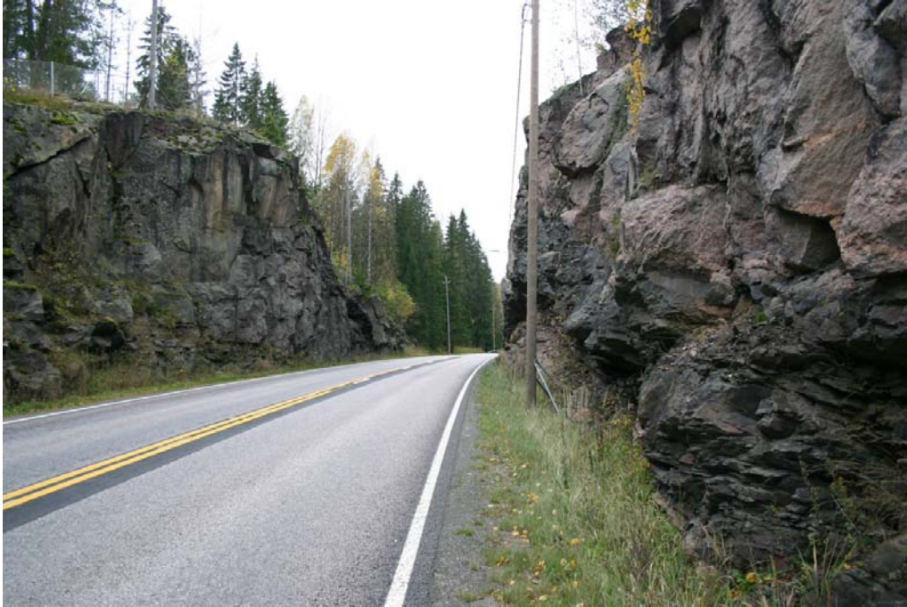
Kuva 17. Kallioleikkaus maantiellä 120 Välillä Helsinki–Vihti.
