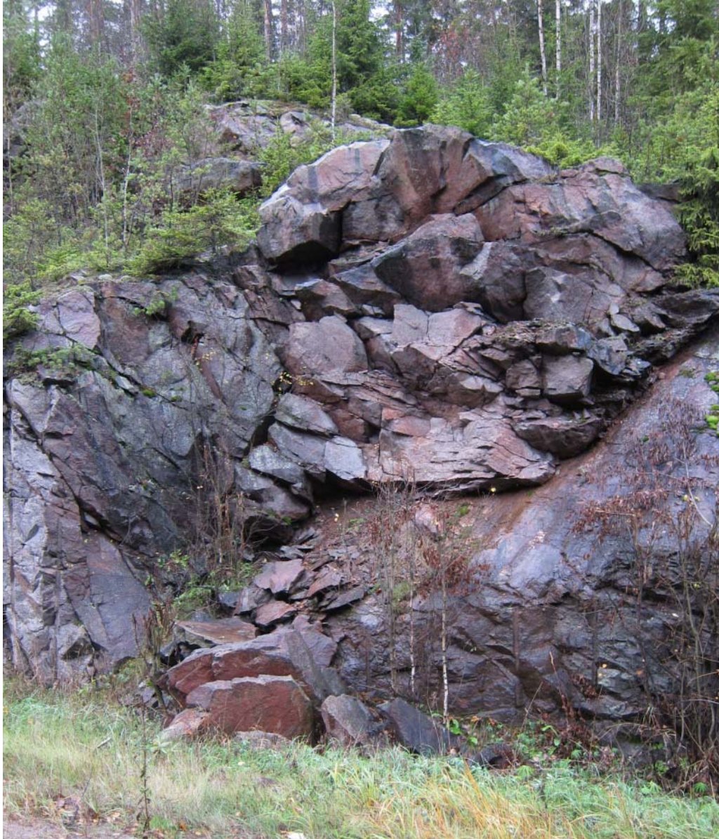
Kuva 10. Tiekallioleikkauksen sortuma valtatiellä 9 Orivedellä. Kuvattu 2014.
