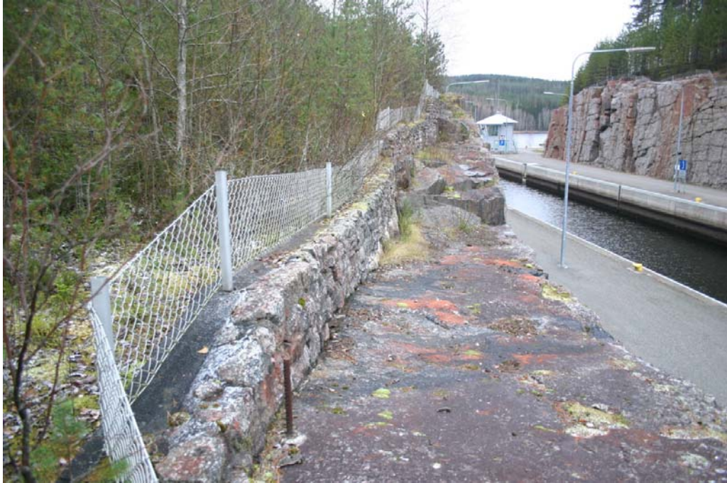
Kuva 31. Kallioleikkauksen yläpuolinen muurirakenne ja suoja-aita.
