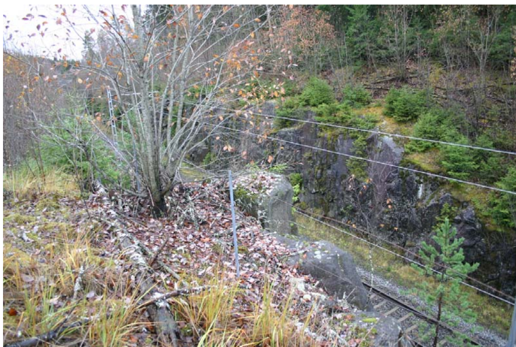
Kuva 24. Kallioleikkauksen suoja-aita ja kasvillisuutta leikkauksen päällä.
