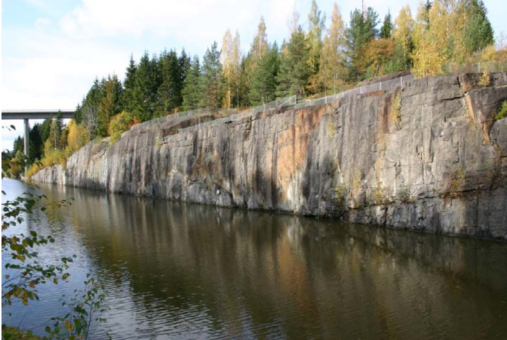
Kuva 19. Vesiväylän kallioleikkausta Saimaan kanavalla.
