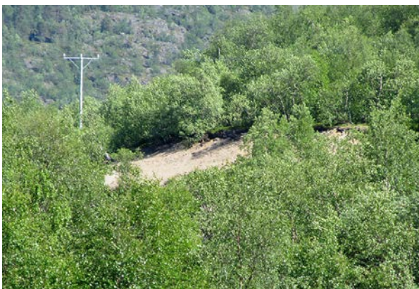
Kuva 187. Eroosiokohteen kuvaus on suoritettu Suomenpuoleiselta tieltä kohteesta ylävirtaan, missä erottuu vain eroosiotörmän yläosa. Kuva: A. Kurkela.
