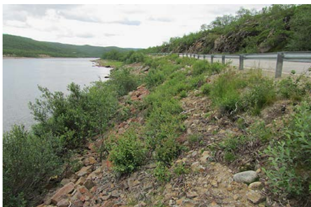
Kuva 107. Suojauksen kohdalla kasvillisuus on vähäinen. Kuva: A. Kurkela.
