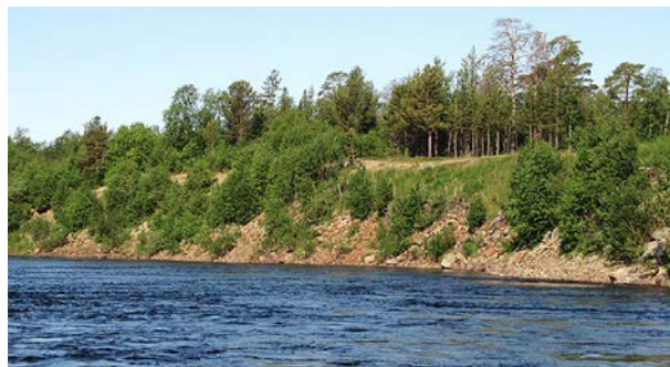
Kuva 216. Roavvenjargan kohteeseen on tehty eroosiosuoja- us. Kuva: A. Kurkela.
