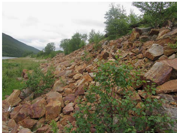
Kuva 154. Kohteeseen on tehty eroosiosuojaus. Kuva: A. Kurkela.
