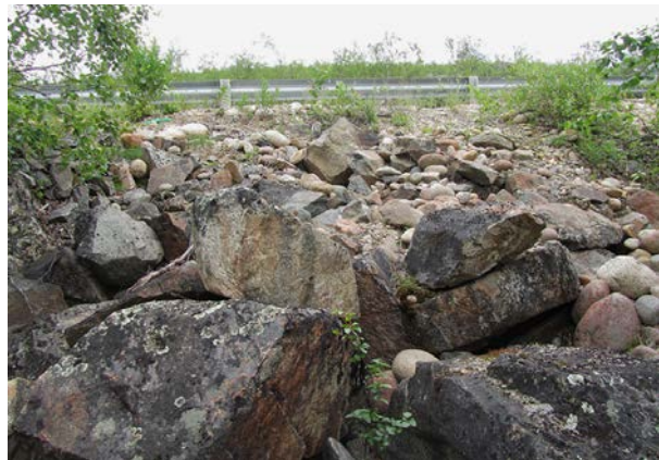
Kuva 104. Kohde on suojattu eroosiolta ja louheella. Kuva: A. Kurkela.
