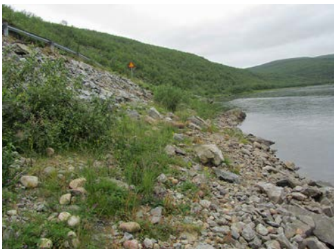
Kuva 93. Kohde on pengerretty tien rakentamisen yhteydessä louheella. Kuva: A. Kurkela.
