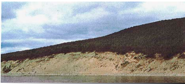
Kuva 45. Sirman eroosiokohde vuonna 1999.
