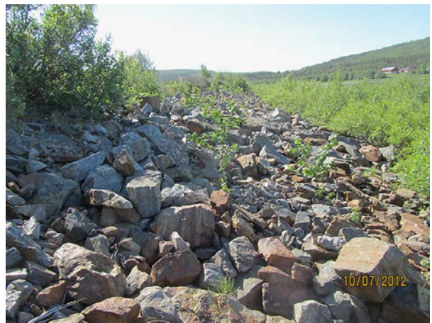
Kuva 205. Eroosiosuojauksessa kivien välistä kasvaa muutamia pajuja ja tunturikoivun alkuja. Kuva: A. Kurkela.
