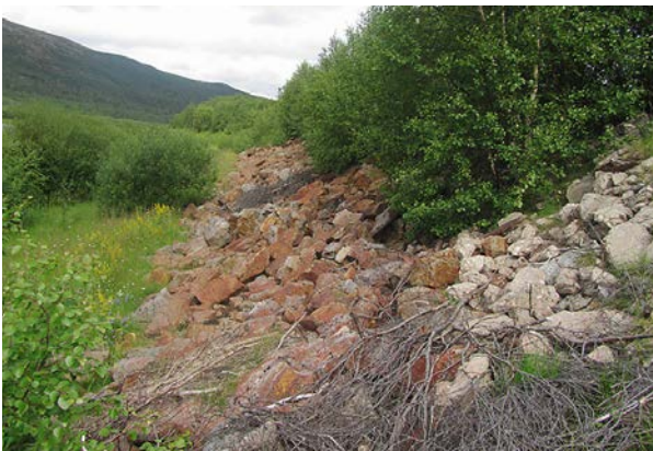
Kuva 148. Kuvassa erottuu selvästi kohteeseen tehty eroosiosuojaus.
