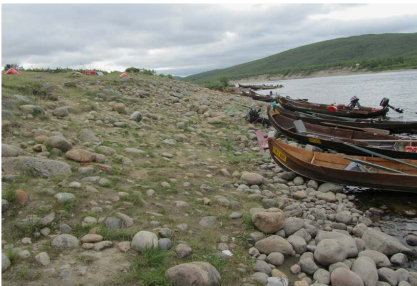
Kuva 73. Eroosiokohteelle on rakennettu veneranta. Kuva: A. Kurkela.
