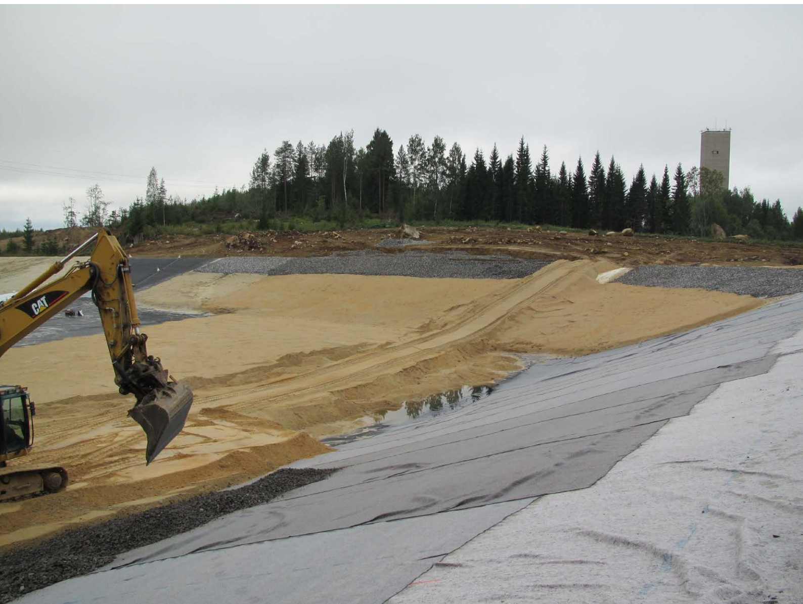
Luikonlahti gruvdamm under byggnad i Kaavi, 2011 (Timo Regina)
